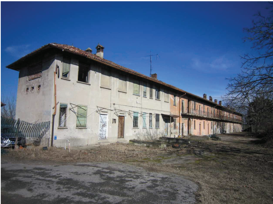
Vista interna edificio salariati
