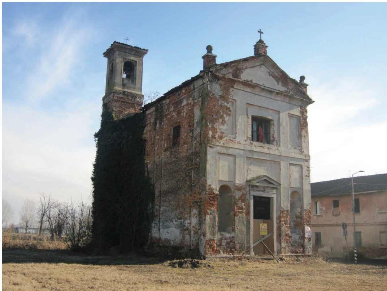
Particolare della facciata principale della ex chiesetta di San Carlo
