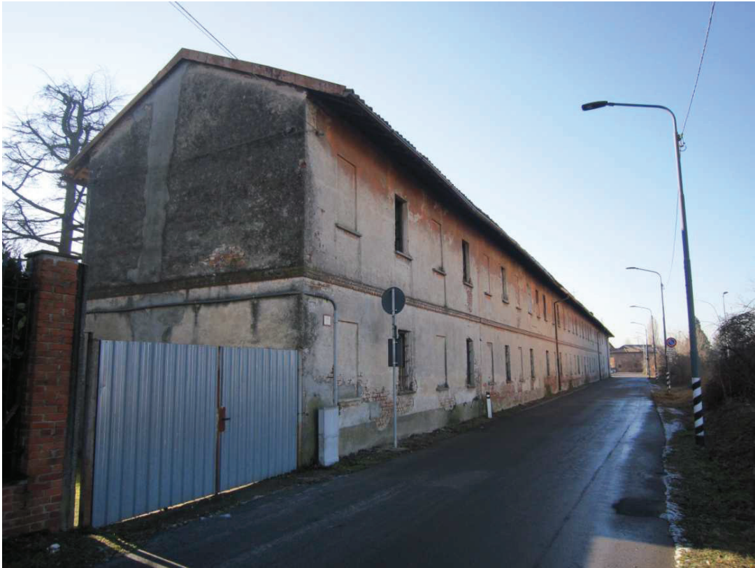
Vista esterna edificio salariati
