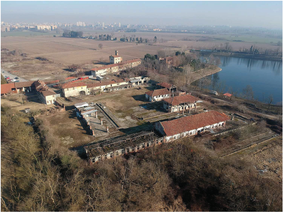
Vista sud: stato di fatto
