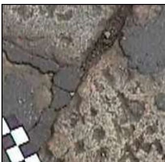
Figura 13: Asportazione di sigillante dai giunti
